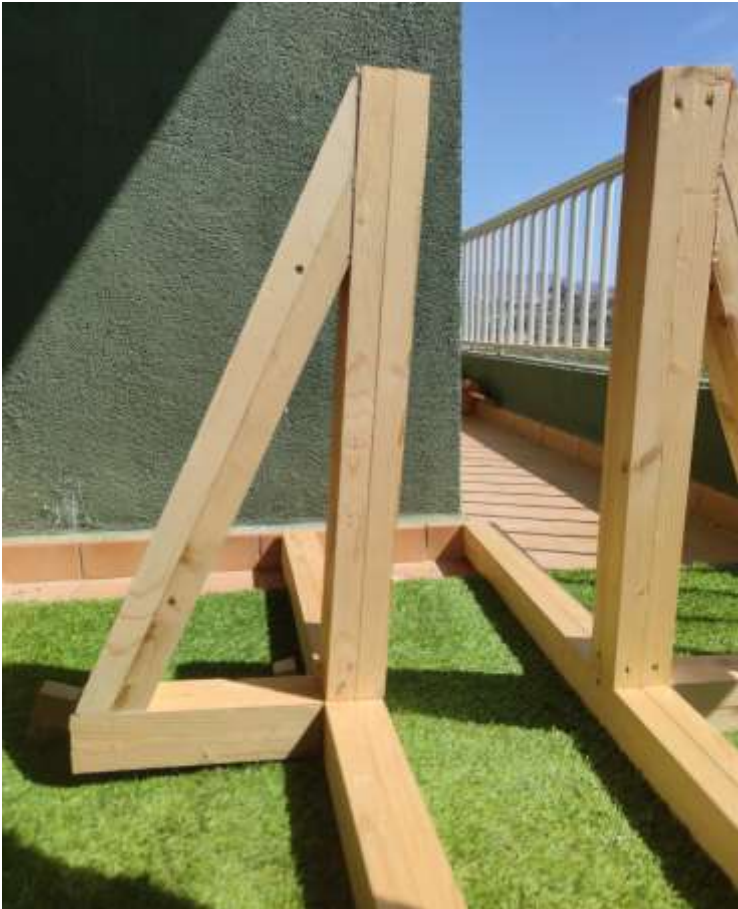
Figura 26: Diagonales laterales unidas a los montantes
