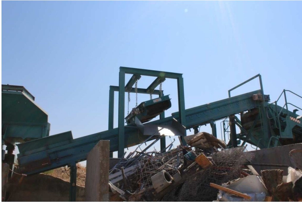
Figura 31. Cinta transportadora CT-01.
