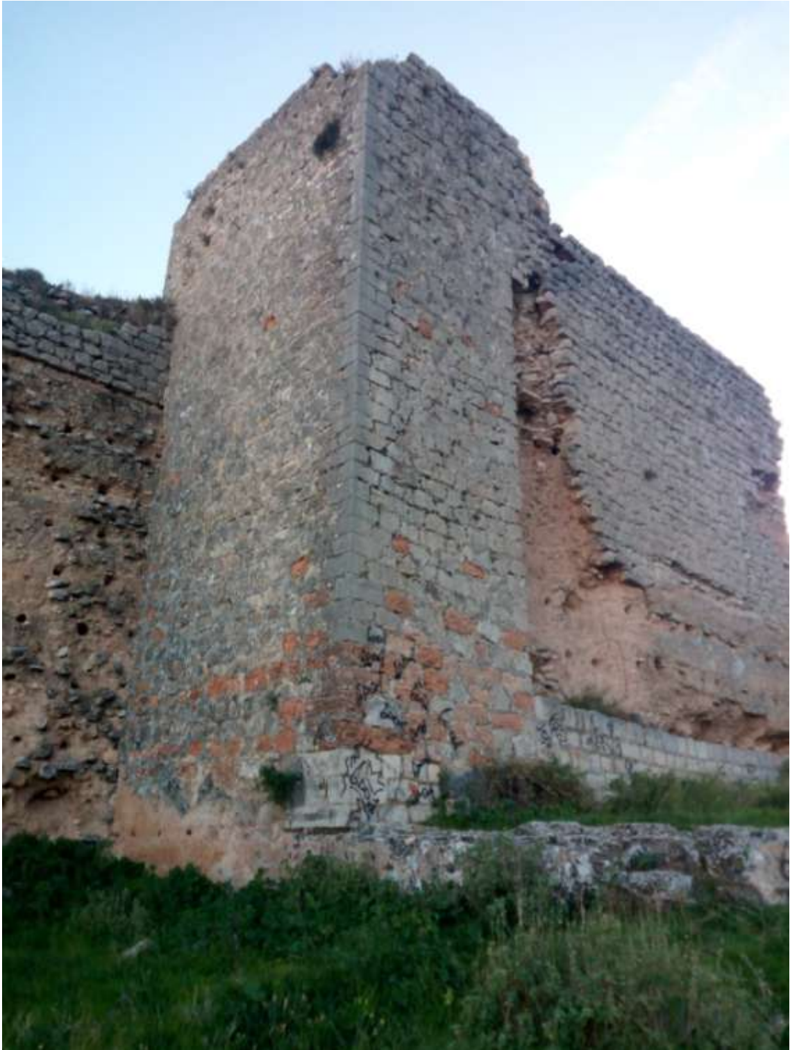
Figura 37. Torre N° 14 (Fuente: Rocío Echevarría).
