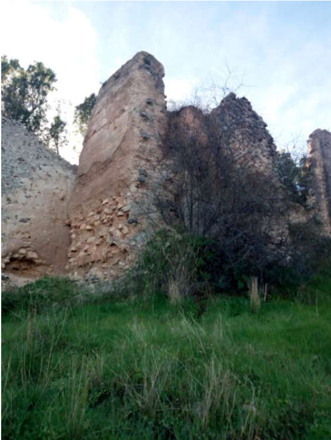
Figura 30. Restos de la Torre 9. (Fuente: Rocío Echevarría).
