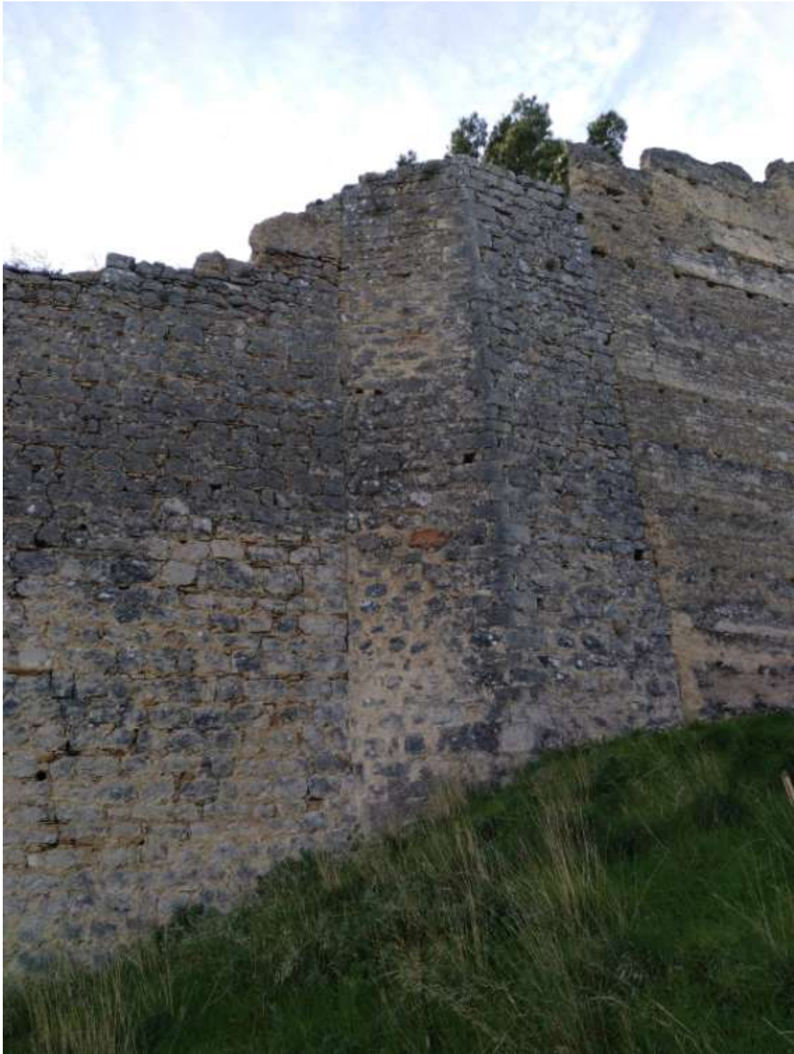
Figura 28. Torre N°8. (Fuente: Rocío Echevarría).
