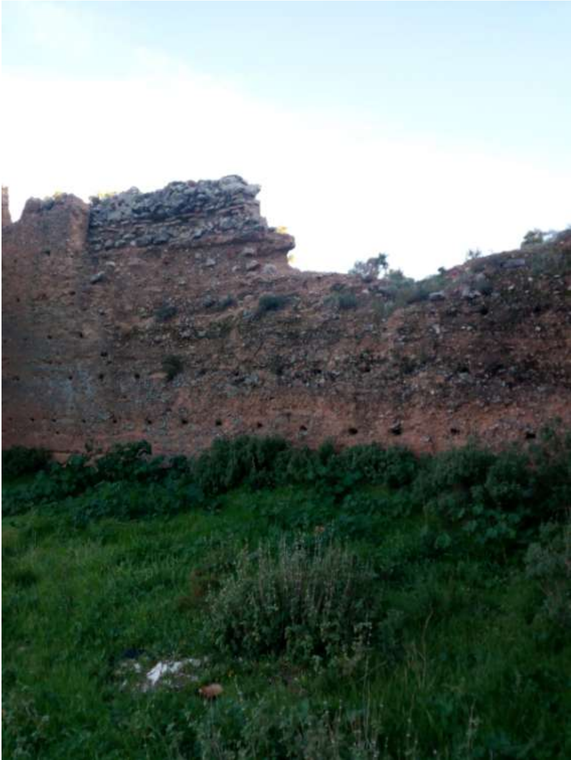
Figura 42. Restos del lienzo de muralla ñ. (Fuente: Rocío Echevarría).
