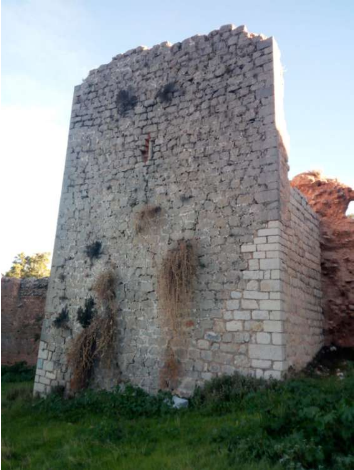
Figura 41. Torre N° 16. (Fuente: Rocío Echevarría).
