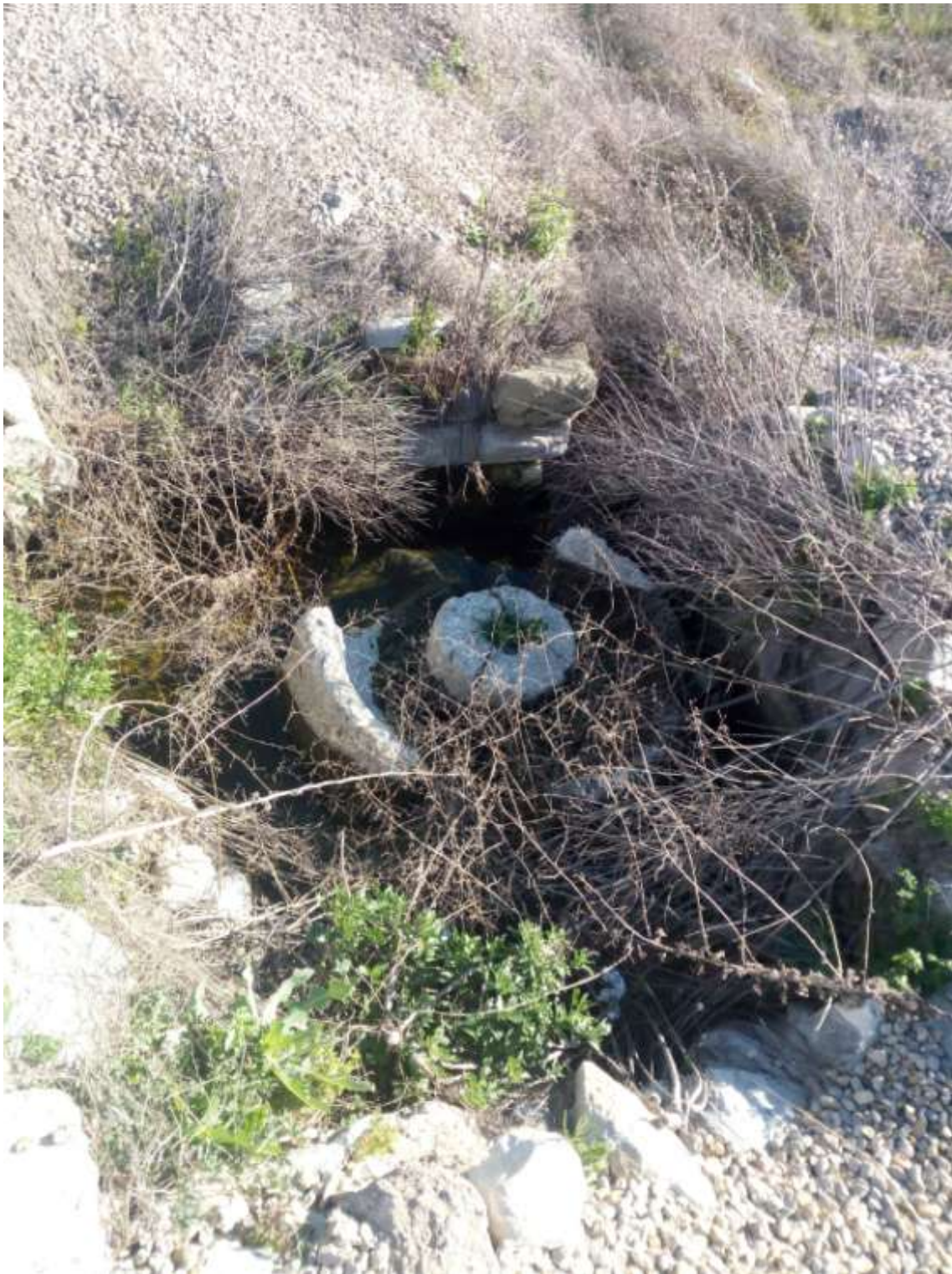
Figura 50. Elementos constructivos anegados, Villa Romana del Cortijo de los Robles. (Fuente: Rocío Echevarría).
