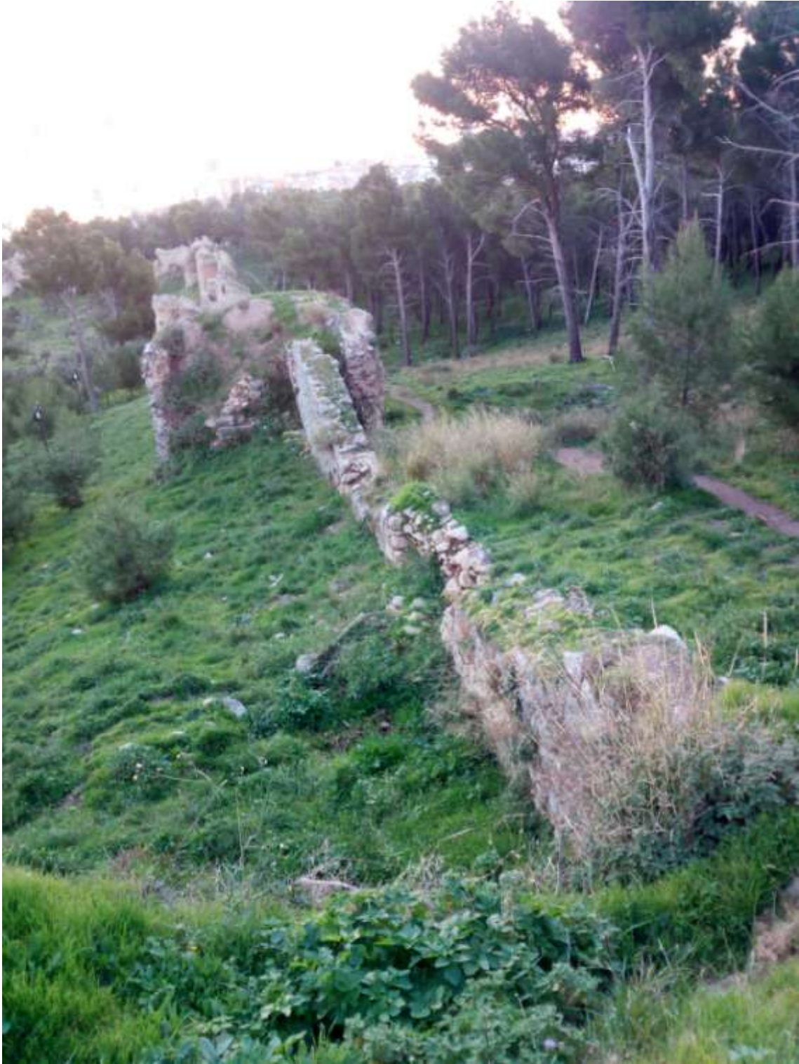
Figura 51. Estado de conservación de la Muralla Norte de la ciudad de Jaén. (Fuente: Rocío Echevarría).
