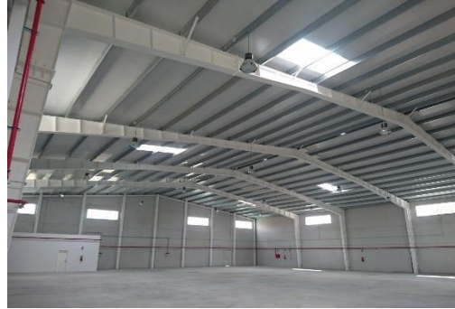
Figura 12. Viga de sección variable
