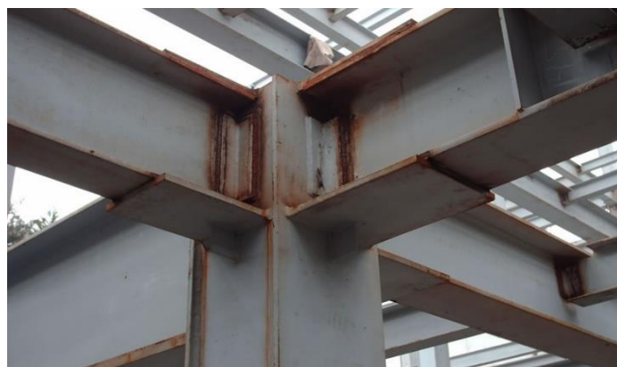
Figura 7. Unión mediante soldadura
