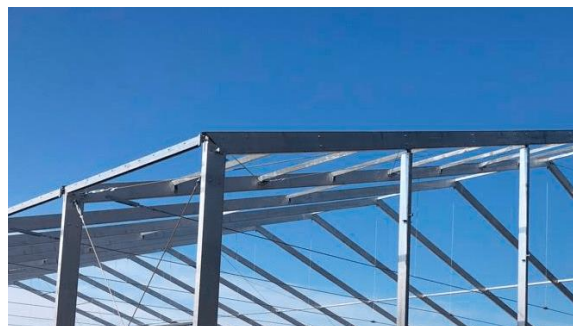
Figura 9. Vigas de atado
