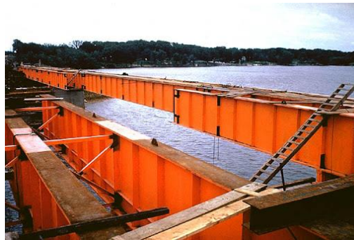
Figura 13. Viga de sección constante
