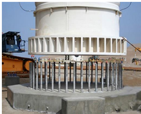
Figura 3. Pernos de anclaje
