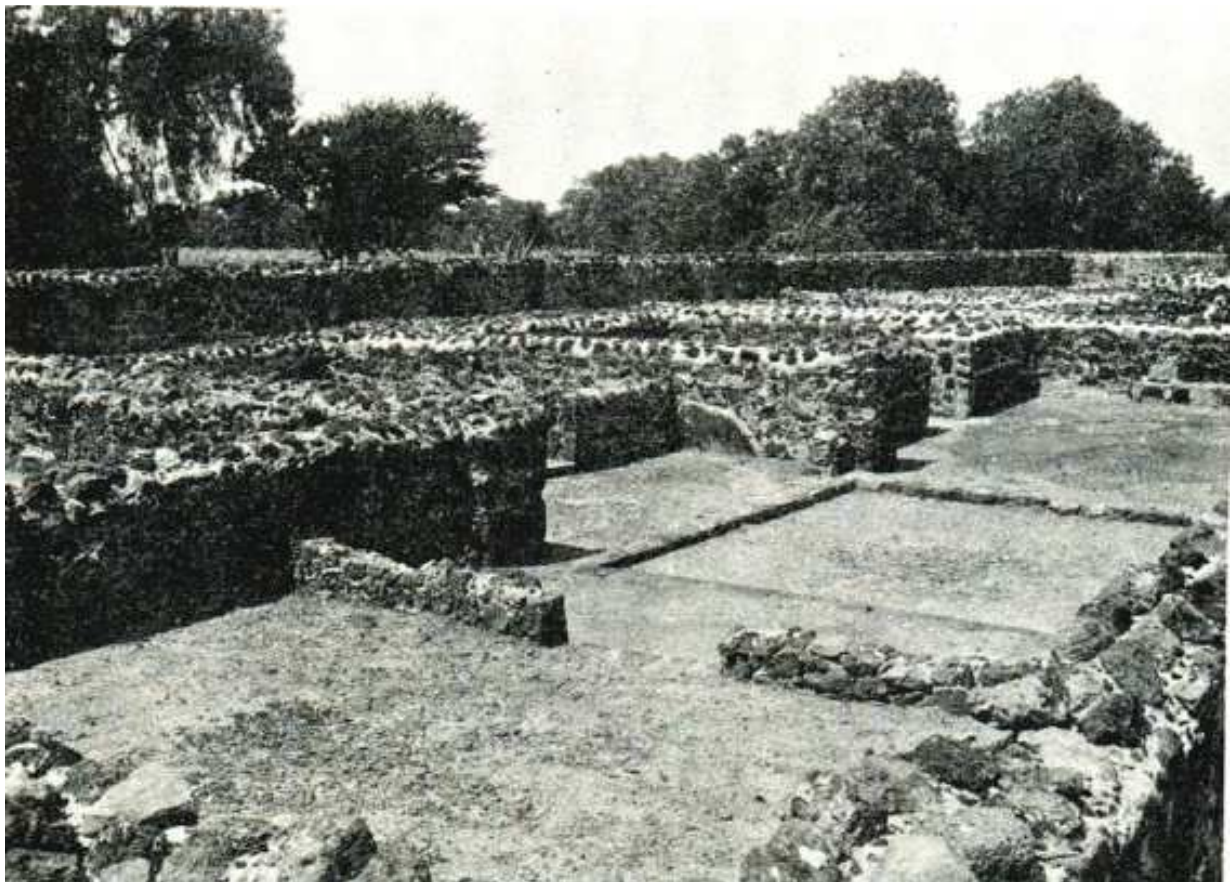
Fig. 7. Patio de distribución. Zacuala, Teotihuacán
