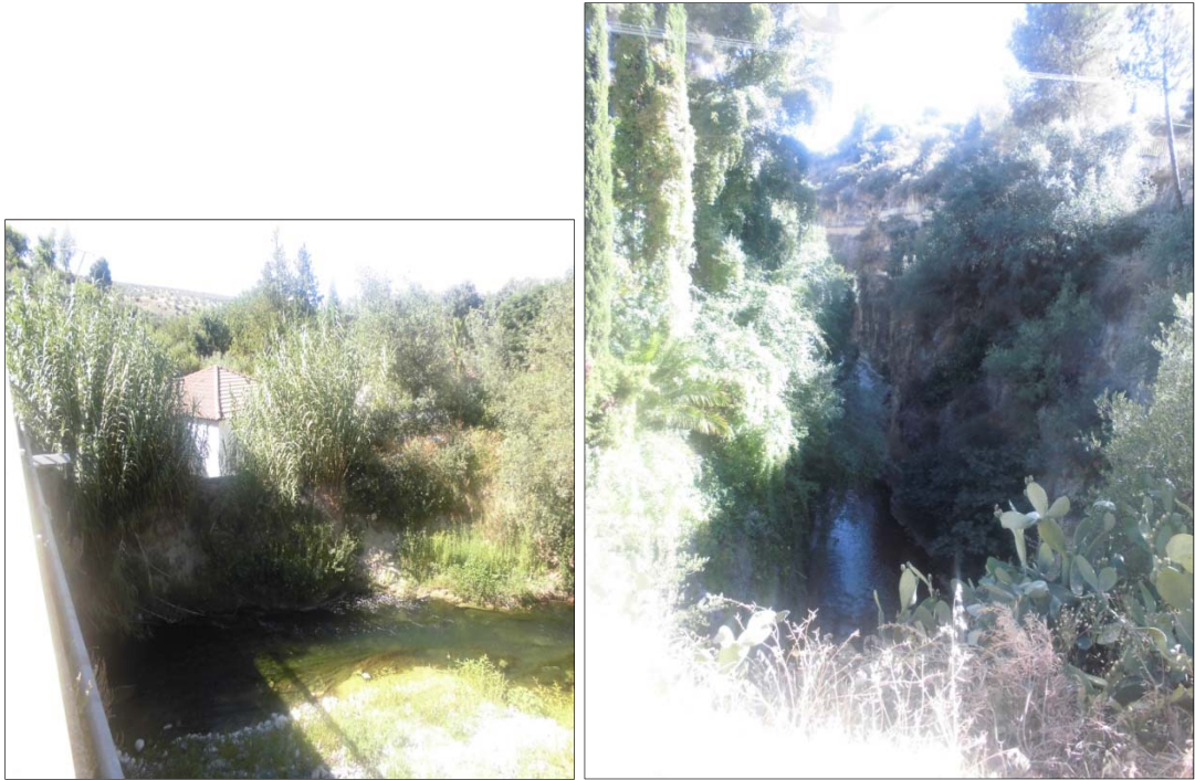
Foto 3: A la izquierda ejemplo de una mala edificación en la llanura de inundación del río Eliche. A la derecha los cañones del río, factor intensificador de las inundaciones.
