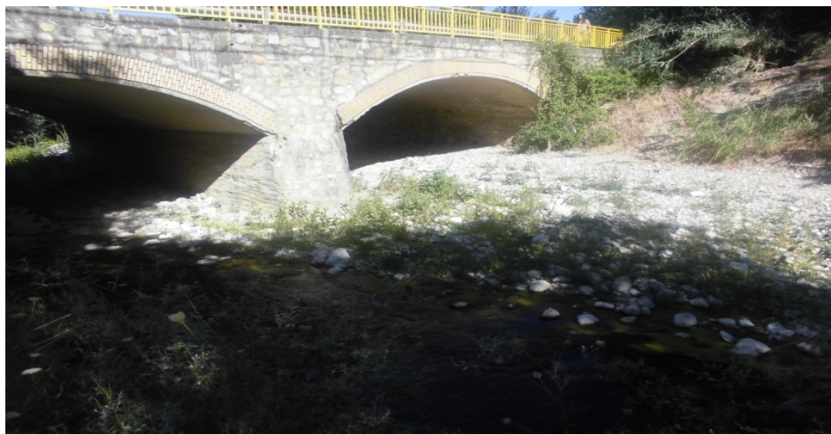
Figura 17.- Puente del río Eliche a su paso por Puente de la Sierra
