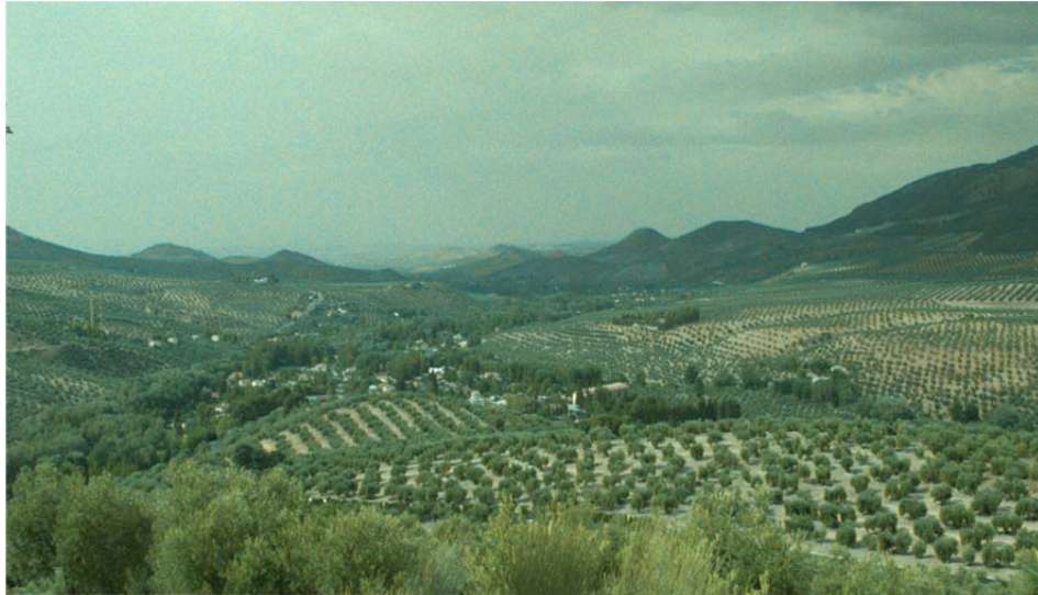
Figura 7.- Localización del Puente de la Sierra en el fondo del valle
