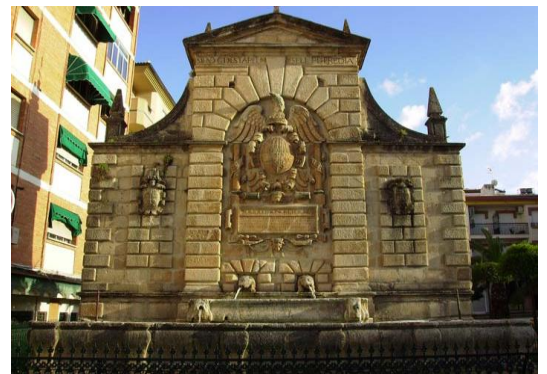
Ilustración 14. Fotografía del Pilar de la Fuente Nueva. Fuente:
