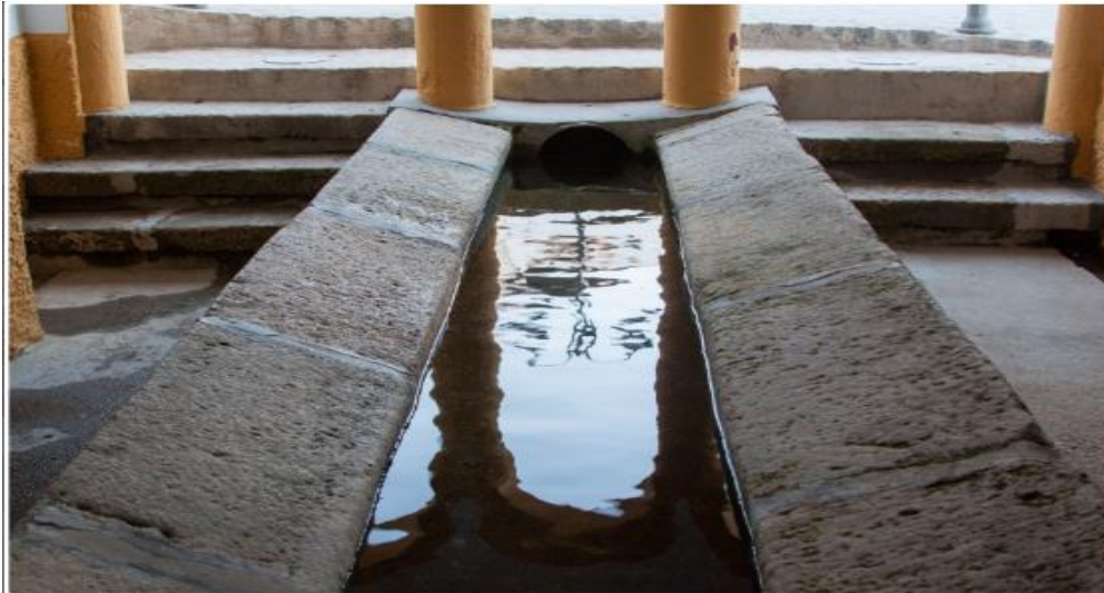
Ilustración 19. Lavadero de Frailes
