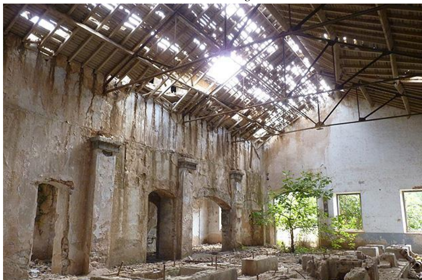
Ilustración 13. Interior de la Antigua Fábrica de la Luz
