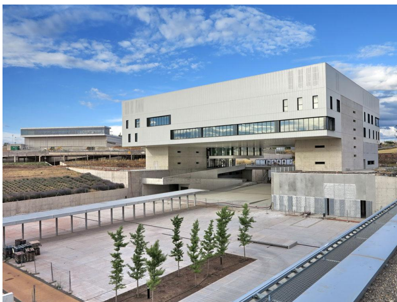
Figura 2.1 Foto del nuevo campus Escuela Politécnica Superior de Linares
