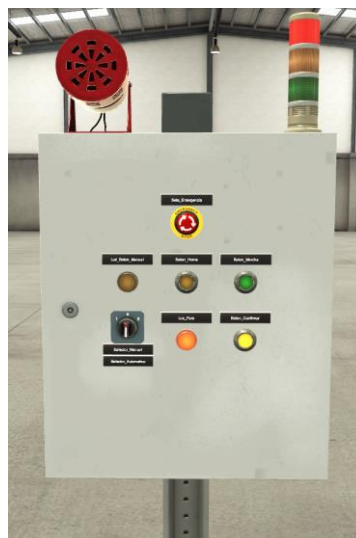
Figura 2.36. Estación modos de trabajo.
