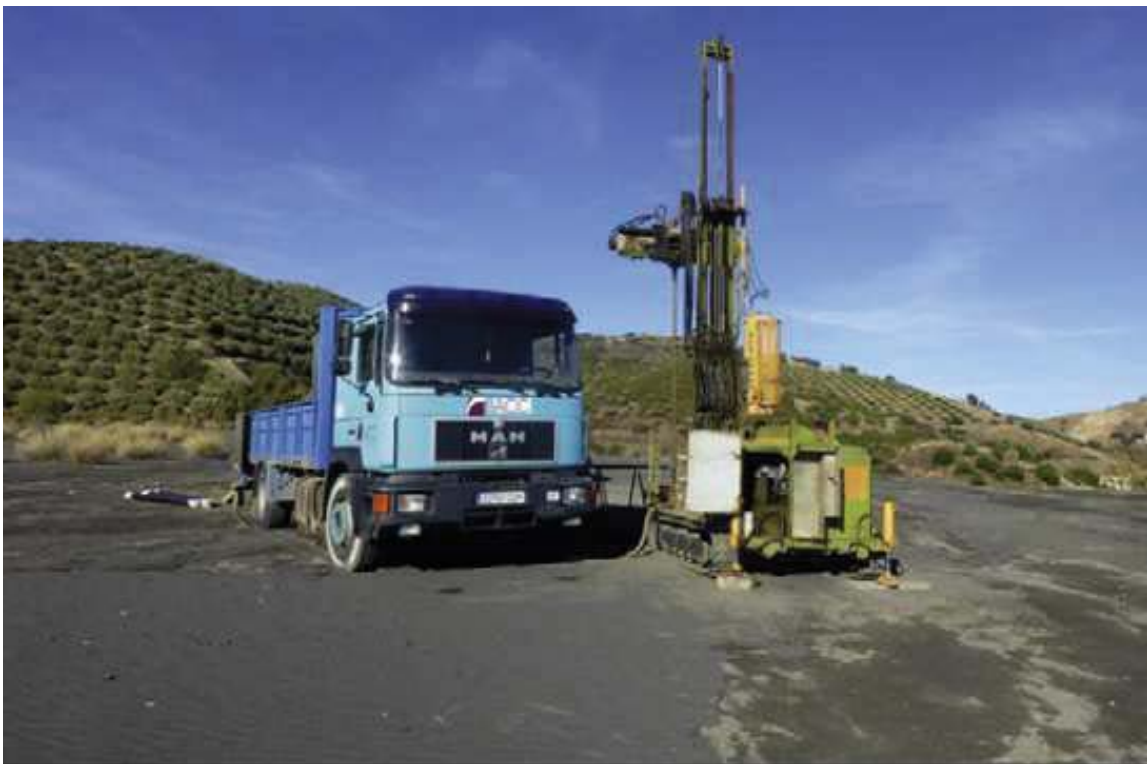
Figura 12. Máquina perforadora para realizar los sondeos.
